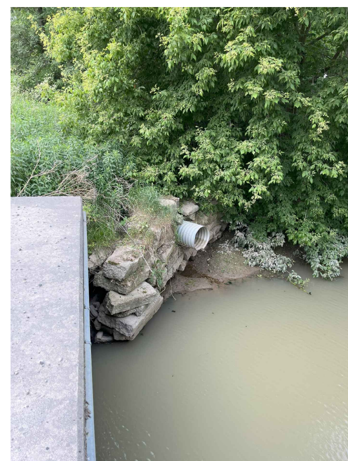
NW CORNER - PHOTO 2 SCALE: N.T.S.
