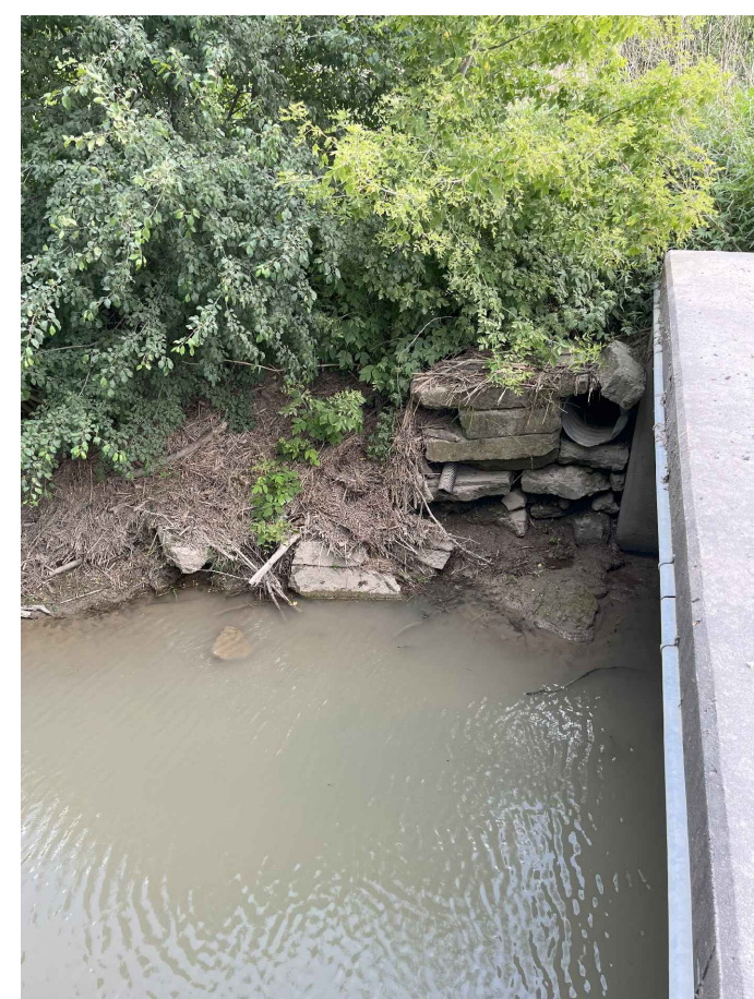
NE CORNER - PHOTO 1 SCALE: N.T.S.
